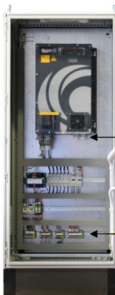
→ Anschlüsse Track-Leitungen 1+2 direkt im Einspeisekonvertermodul
