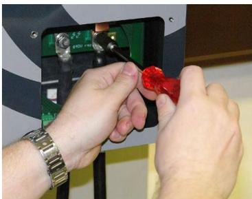
Abb. 19: Anschluss Track-Leitung mit montierter Abdeckplatte
