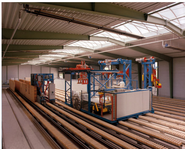
BU: Motorleitungstrommel Sprinter an einem Fertigmauerwerk
